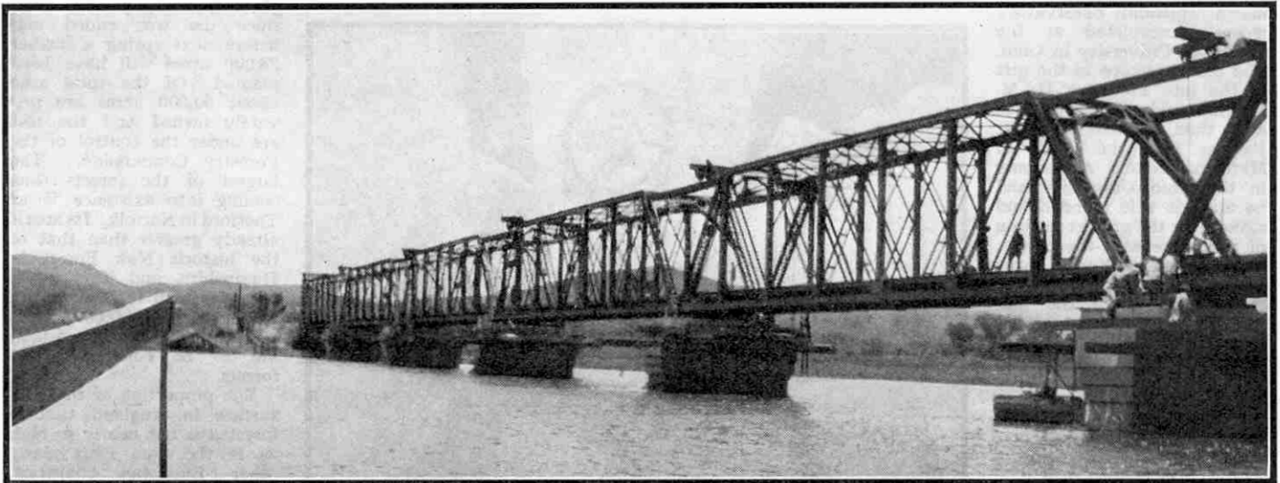
Raising the bridge over the Kafue River, Rhodesia
