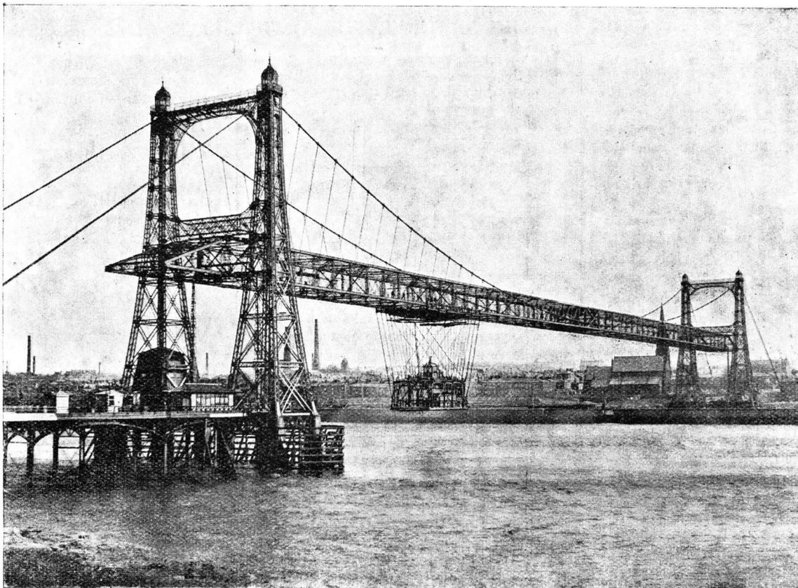
Ce dernier est composé de deux tabliers et d'une plate-forme supportant la voie sur laquelle roulent les 60 roues du chariot transbordeur.
