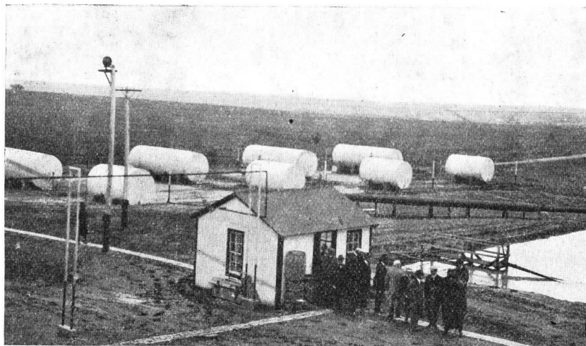
Réservoirs (Tanks) à Huile, Rangers (Texas)
