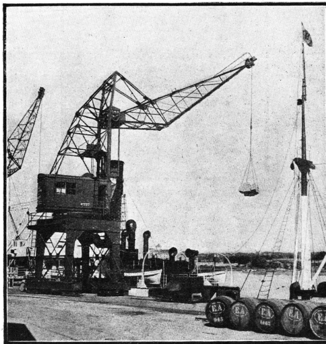
Grue électrique de 3 tonnes à portée variable
