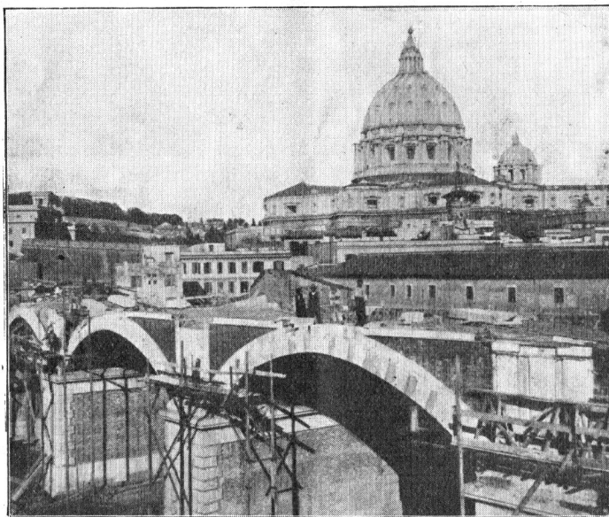
Vue prise pendant la construction du Viaduc.
