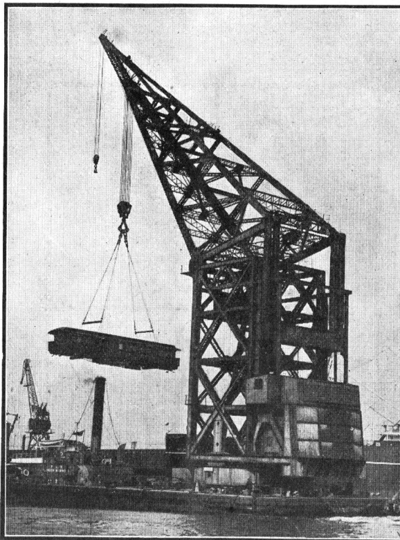
Une Grue qui soulève 30 tonnes
