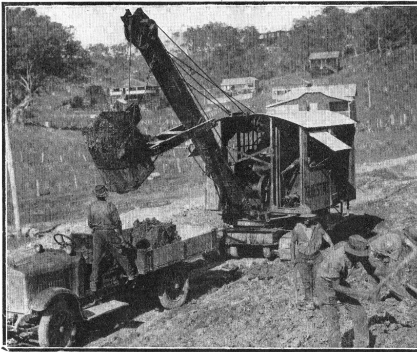
Un excavateur universel de 15 tonnes.
