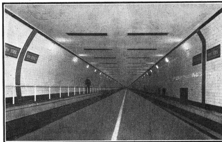
Les lignes verticales sur les parois du tunnel marquent la frontière entre les Etats de New-York et de New-Jersey.
