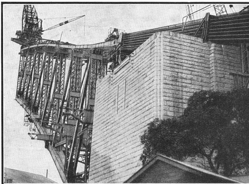
Vue détaillée de la partie sud de l'arc en construction. A droite, on voit les énormes câbles servant à ancrer la gigantesque charpente d'acier.
