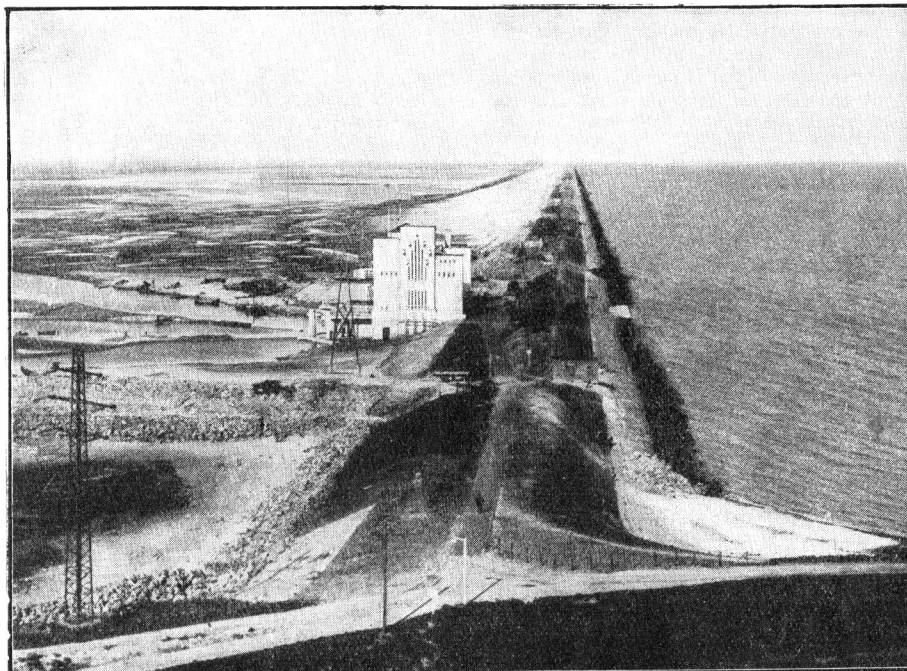
Vue d'une des stations de pompage (station de Lely, près de Medemblik). A gauche, le polder; à droite, le Zuiderzée
