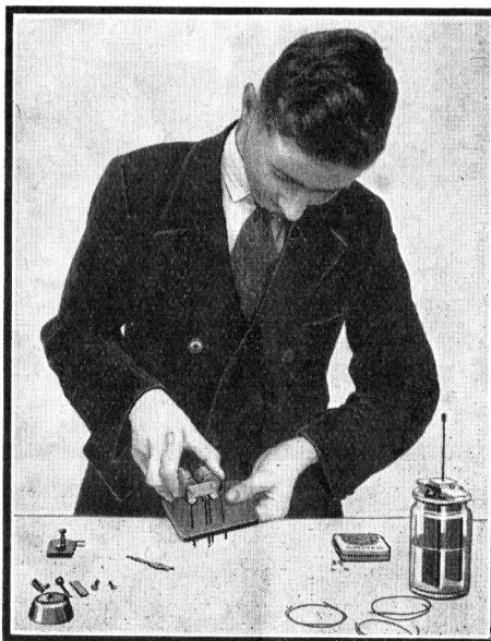
Montage de l'électro-aimant pour la Sonnette électrique.
