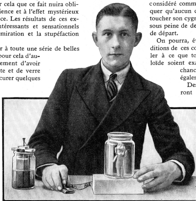
Fig. 1. — Une poupée lestée à l'aide de petits clous en fer et plongée dans l'eau se met à « danser » sous l'action d'un électro-aimant dissimulé dans le support.
