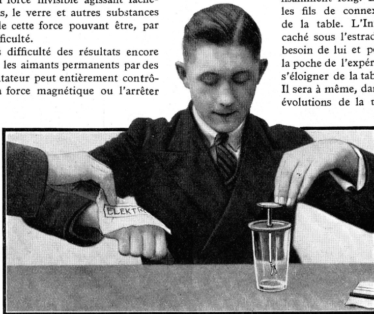
Fig. 2. — On électrise l'expérimentateur en lui frottant la main avec le carré de soie. Le phénomène de l'électrisation est révélé par l'écartement des feuilles de l'électroscope.
