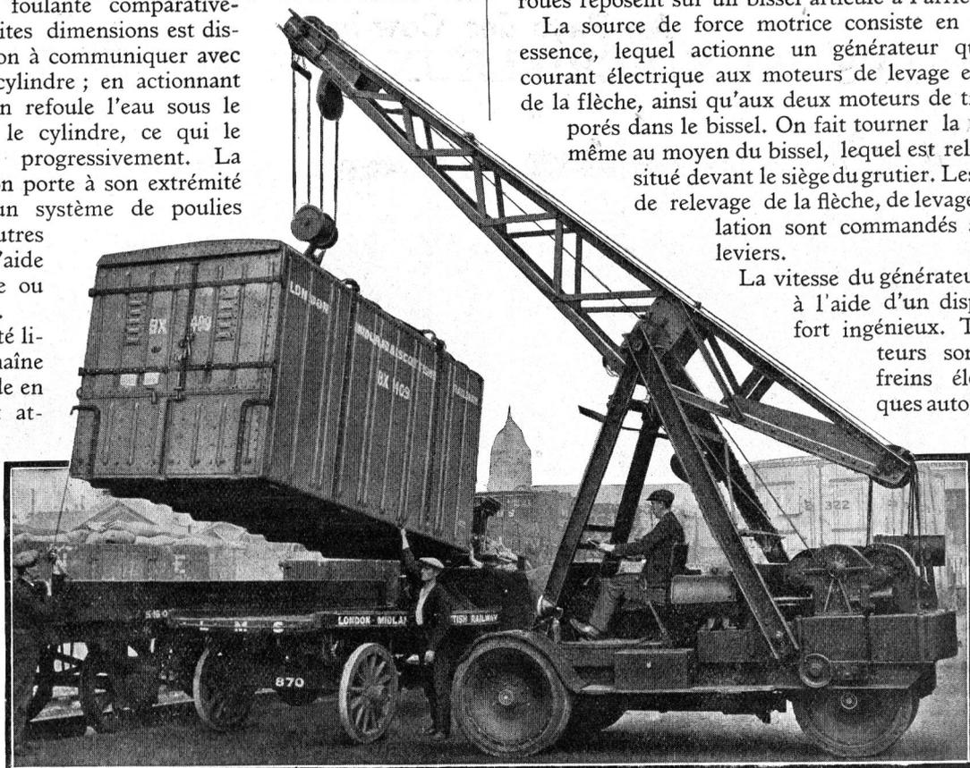
Grue mobile électrique manipulant une charge volumineuse.
