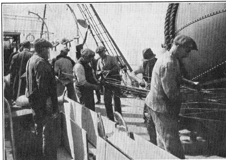
Réparation d'un câble endommagé.
