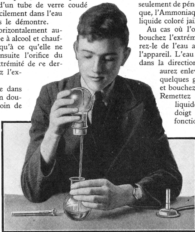
Fig. 1. — Une fontaine chimique en action.
