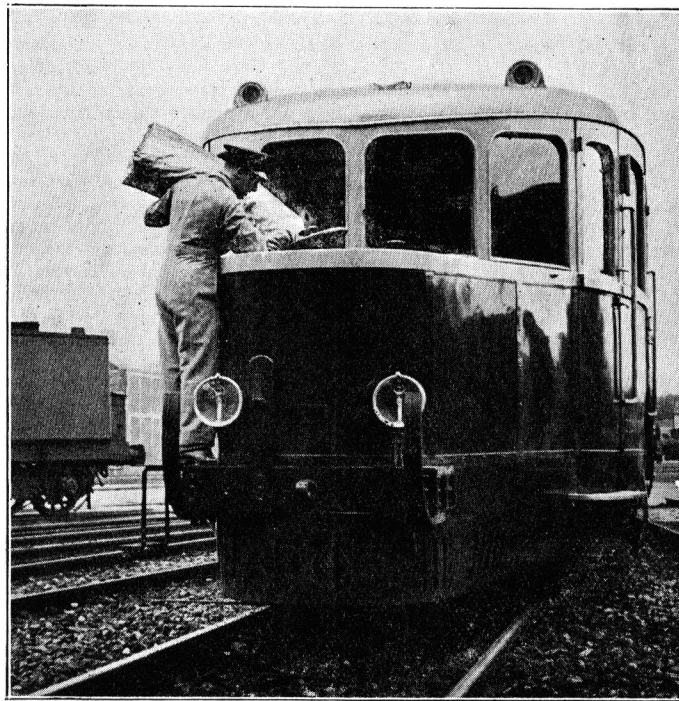
Le chargement du charbon de bois dans l'aurorail à gazogène décrit sur cette page. Ce cliché nous a été confié par la revue « Le Génie Civil ».
