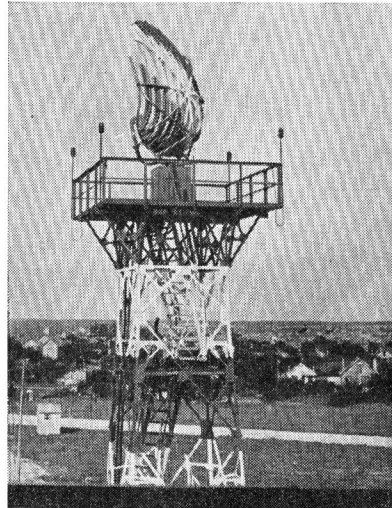
Le radar de surveillance vu de la tour de contrôle.
