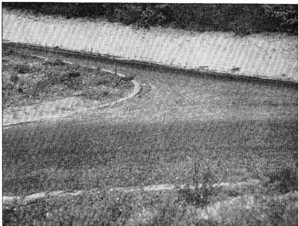
Pistes de la Régie Nationale des Usines Renault à Lardy (Seine-et-Oise). On voit le départ de la pente à 20 % qui coïncide avec la jonction des deux pistes.
