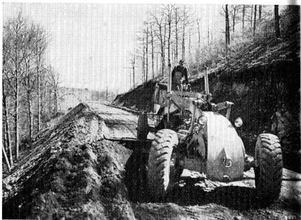
Le jeu des quatre roues de la niveleuse Richier permet un décentrement qui équilibre la poussée du terrain sur la lame. Cela permet un travail en crabe ou en biais et évite le passage des roues arrière sur le travail fini.
