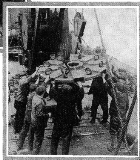
(Arriba) Las operaciones de fondeamiento. El enorme cabrestante es operado por maquinillas a vapor. (Centro) Arriando la primera porción del eje por el pozo de la quilla. (Derecha) Embarcando la cabeza del cabrestante el cual se monta en la extremidad del eje y las barras del cabrestante se insertan en los agujeros cuadrados.
