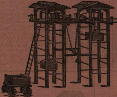
Das Bauspiel führt uns einen Aufzug vor, wie solcher in Bergwerken und vor allen in Schieferbrüchen angewendet wird. Aus Balken und Stäben gezimmert ist es ein zierlich Bauwerk. Durch Umdrehung der Kurbel werden die Förderkasten in Bewegung gesetzt, von denen der eine auf und der andere abwärts geht.
