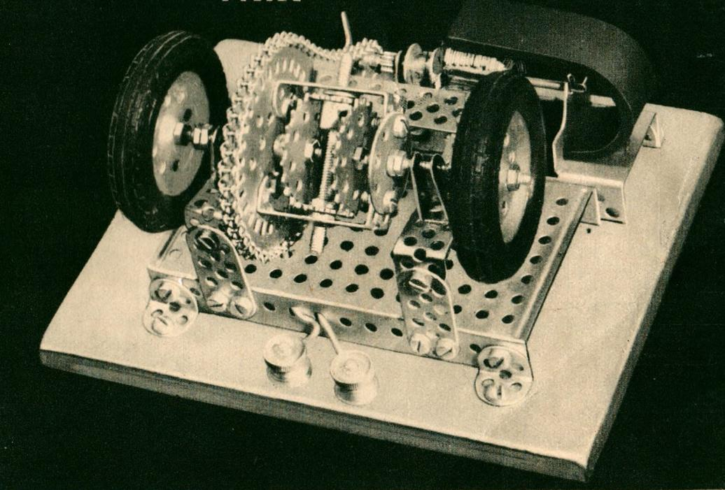
**DIFFERENTIEL.** Apprenez le système de fonctionnement du différentiel qui fait partie du pont arrière d'une auto. Vous pouvez construire ce modèle, qui fonctionne avec votre boîte ELEMEN-TRIX plus 1 boîte "C", 1 boîte "G", 2 bandages en caoutchouc, et 1 moteur électrique 2051.
